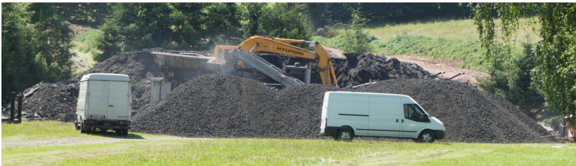
(Baustelle auf dem gewohnten Zeltplatz)
